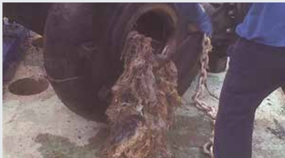
Un empleado de Emasesa retira restos sólidos y toallitas húmedas de la red de saneamiento de Sevilla
