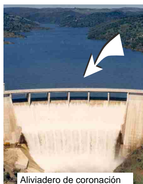
Aliviadero de coronación
