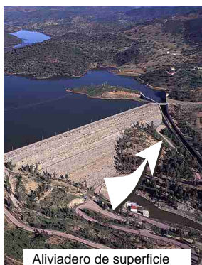
Aliviadero de superficie
