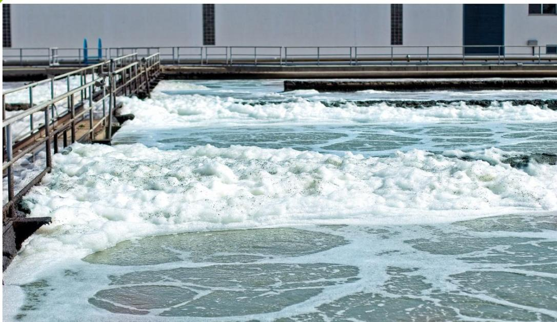
SE SOMETE AL AGUA A UN PROCESO DE **AIREACIÓN** MEDIANTE TURBINAS O POR BURBUJEO DESDE EL FONDO
